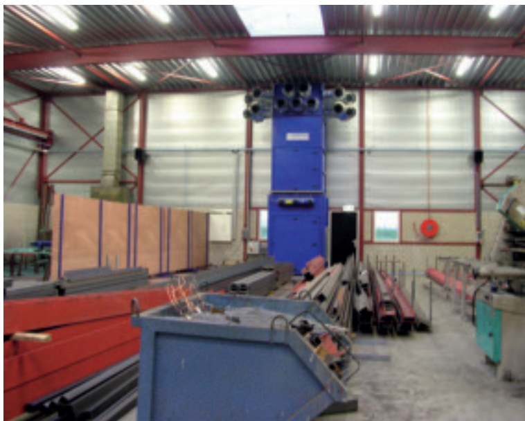
Een bedrijfshal waar een afzuiginstallatie van Lemtech succesvol wordt ingezet
